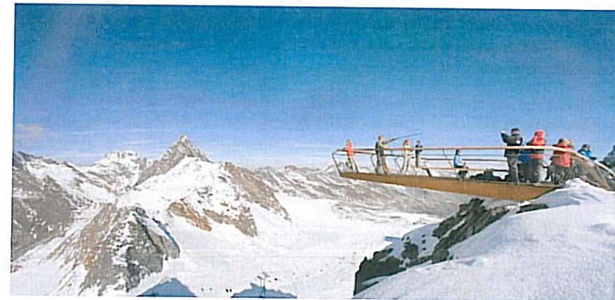
Abb. 28: Die neue Gipfelplattform „Top of Tyrol“.
